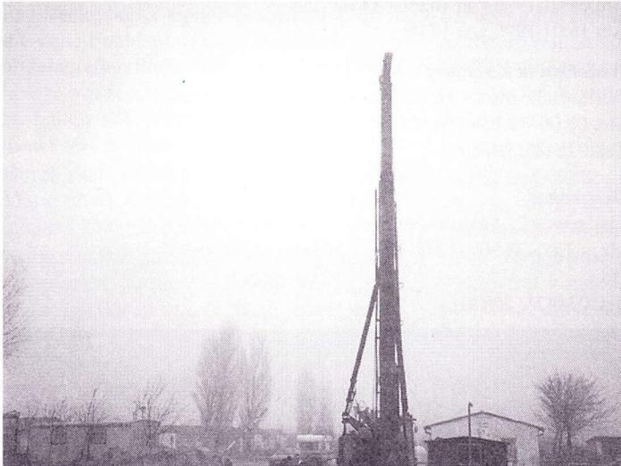
Wegen des moorigen Untergrundes mußten an Stelle eines Fundamentes 11 Meter lange Betonpfähle mit dieser Ramme in den Boden getrieben werden.
