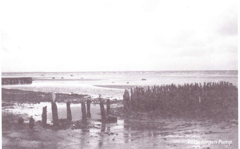
Wie auf dem Foto zu erkennen ist, sind die hier gerammten Buhnen u. a. durch Verwitterung und den Schiffsbohrwurm sehr stark beeinträchtigt.
