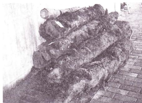
Die Taucher hatten alle Mühe, diese eisenharten Eichenpfähle mit der Kettensäge zu trennen. Hier ein Teil der durchnummerierten Stücke unterhalb der Brücke bei der Zwischenlagerung.
