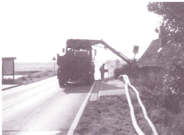
*Nach der 130 Meter langen Bohrung konnten problemlos die Plasterohre durchgezogen werden, in der Tage später die E-Leitungen Platz fanden.*
