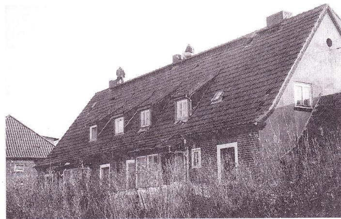
*Die Umbau- und Rekonstruktionsarbeiten haben am alten Lotsenhaus in Timmendorf begonnen. Hier sind es zwei Bauarbeiter, die die Schornsteine abtragen.*
