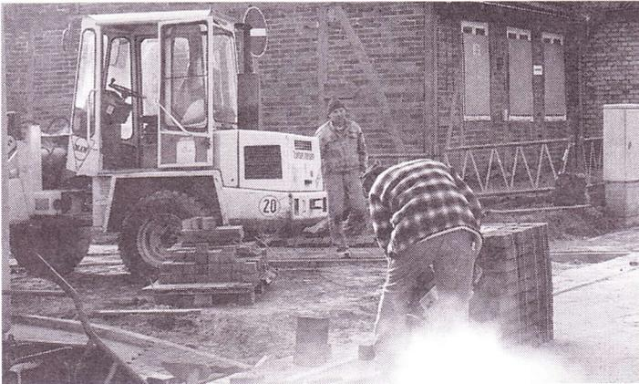
Hier im Foto sind Mitarbeiter mit dem Verlegen von Formsteinen für die Bürgersteige beschäftigt. Zum Aufbringen der Deck-Bitumenschicht benötigt die Straßenbaufirma höhere Temperaturen, so dass erst im Frühjahr 2000 mit der Fertigstellung der Straße zu rechnen ist.
