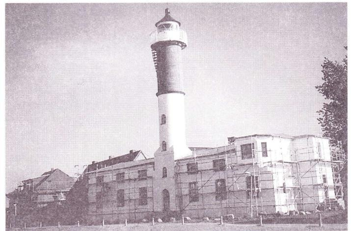
Noch ist das Gebäude um den Timmendorfer Leuchtturm eingerüstet. Das Haus bekommt neben der Wärmedämmung auch einen neuen Putz.
