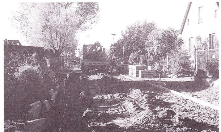
Zur Zeit sind die Bauarbeiter damit beschäftigt, die Leitungen für die Oberflächenentwässerung zu verlegen.
